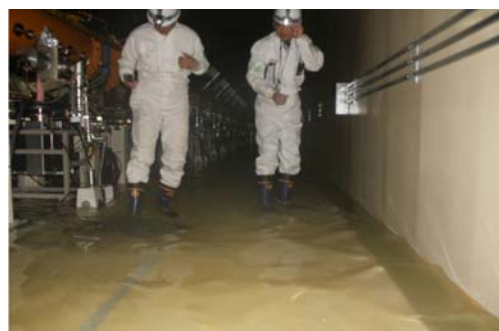
図 1a. リニアックの地下水(約 pH11)による浸水 (資料提供：JAEA/KEK J-PARC センター；下図 1b, c も同様)
