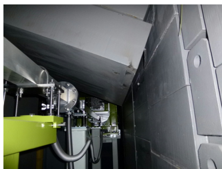
図 1c. MLF BL20 (iMATERIA) の崩落しかけた遮蔽体
